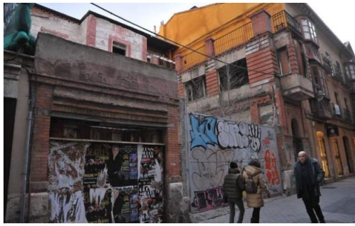
Fachada de Villa Julia, en la céntrica calle Zúñiga. / RODRIGO JIMÉNEZ
